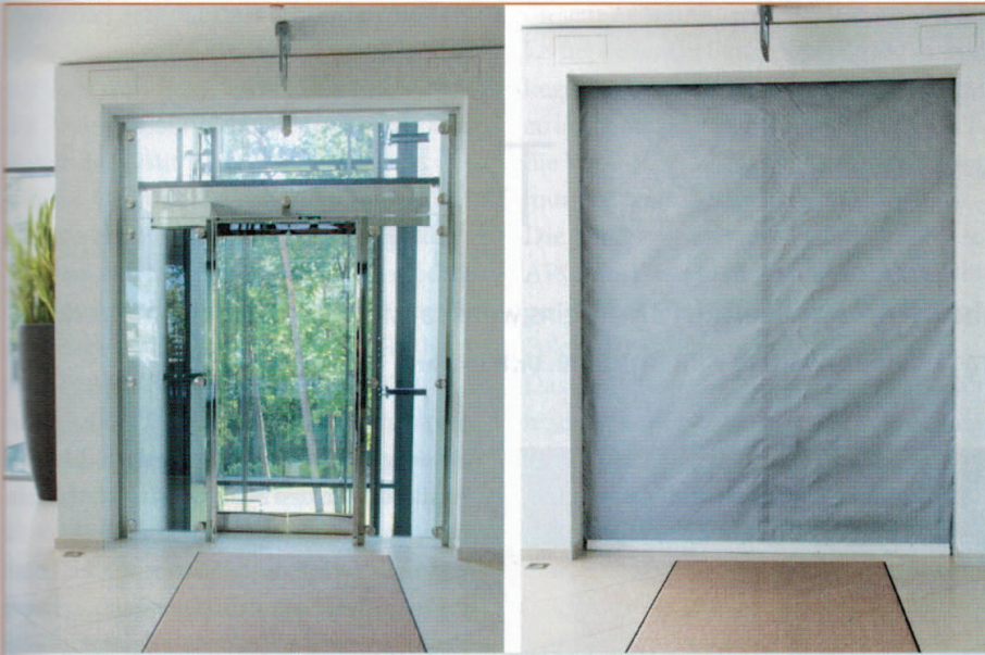
Abb. 2: Rauchschutzabschluss für nicht rauchdichte Aufzugstür
